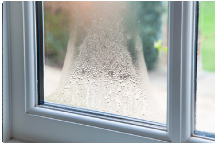
Figuur 16 : Condensatie op de spouwzijden van een beglazing.
